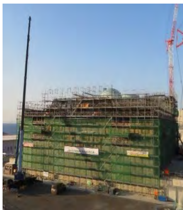
現地工事の様子
