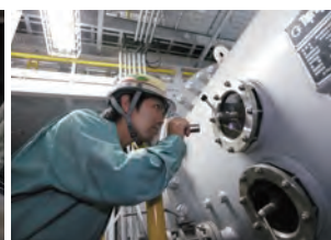
復水器の目視点検
