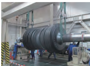
高圧タービンの吊り上げ
