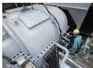
蒸気タービン周りの点検
