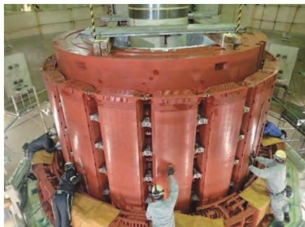
発電機のローター吊り込みの様子
